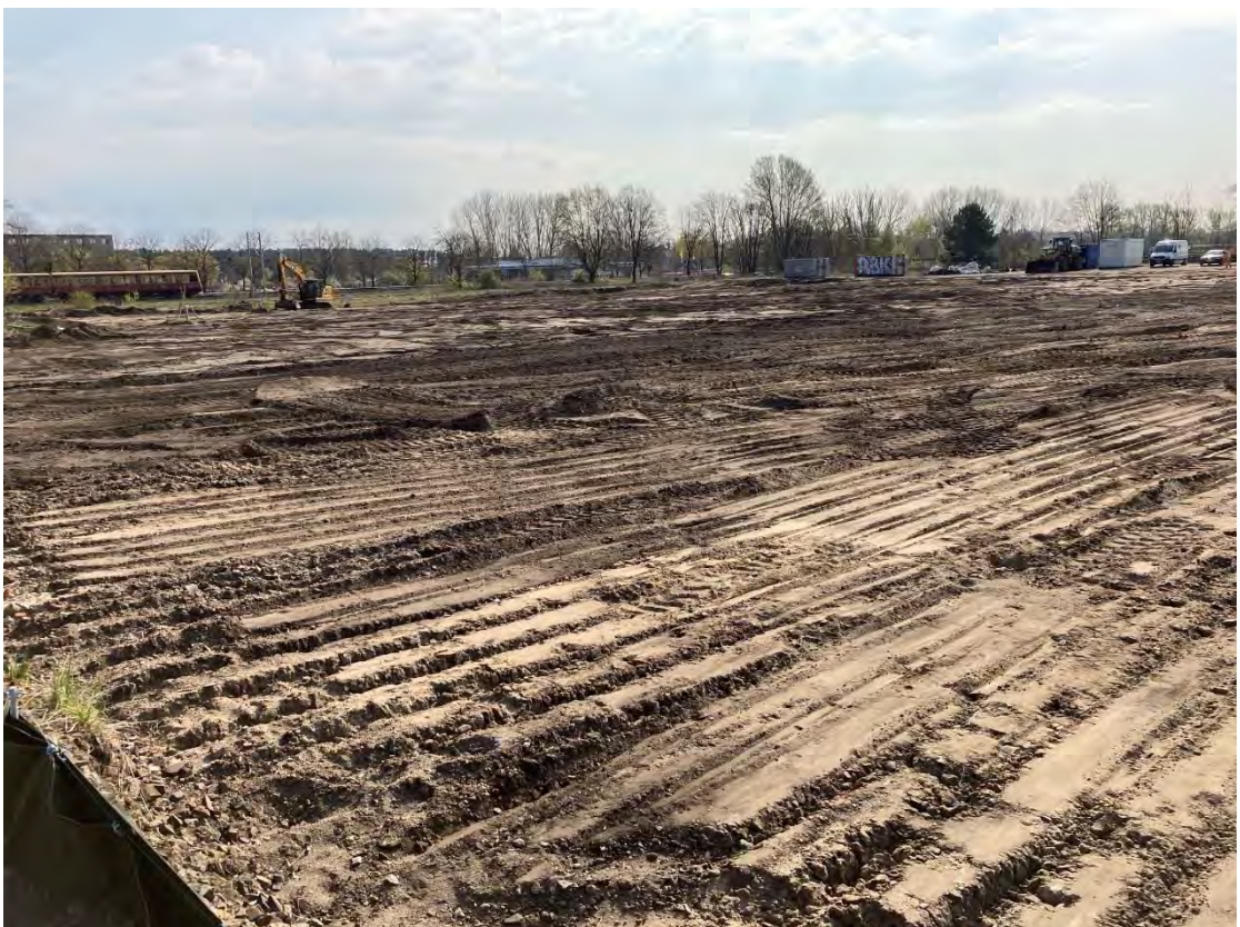
Foto Nr. 4: Ansicht RF 20 10 12 – beräumte Fläche, Blickrichtung: südöstlich
