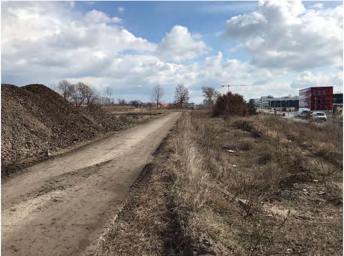
Foto Nr. 3: Ansicht RF 20 10 13, Blickrichtung: südöstlich
