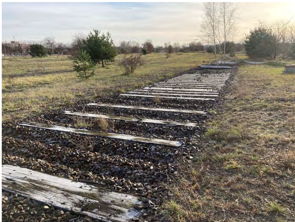
Foto Nr. 2: Ansicht RF 20 10 19, Blickrichtung: südöstlich
