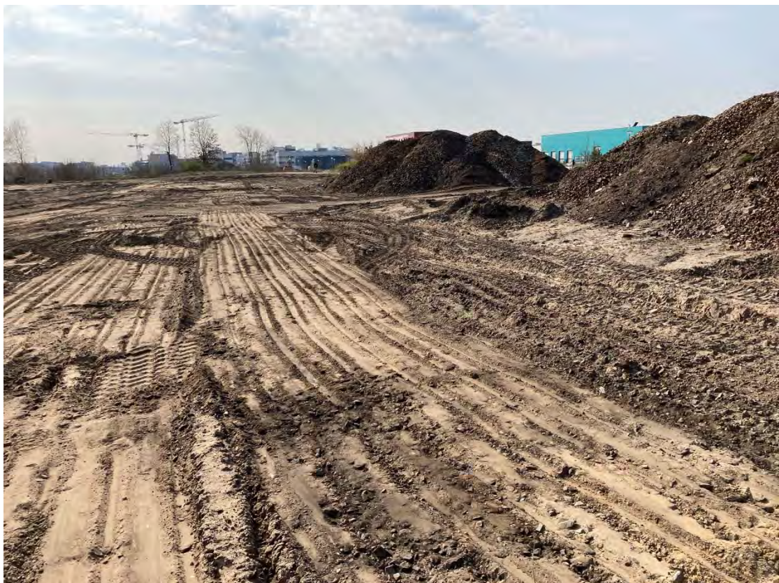
Foto Nr. 2: Ansicht RF 20 10 13, hier: 2021 beräumte Fläche, Blickrichtung: südöstlich
