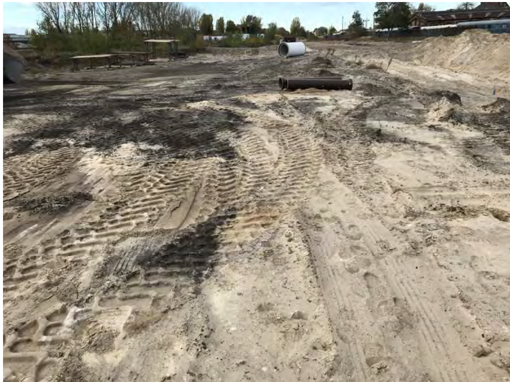
Foto Nr. 3: Ansicht RF 20 10 37, Blickrichtung: nordwestlich, Stand: 30.10.2018
