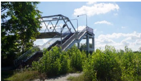
Die aktuelle Treppe von der S-Bahnhaltestelle Betriebsbahnhof Schöneweide © DB Immobilien
